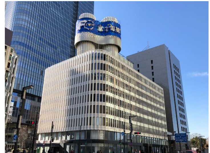
有楽町 東宝ツインタワービル
